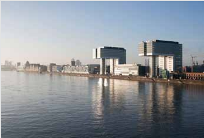
Kranhaus Mitte, Köln, Deutschland
